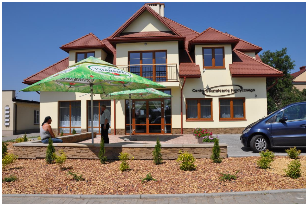
Fotografia nr 43 - Projekty samorządu powiatowego w Strzyżowie: Budowa Centrum Kształcenia Praktycznego w Czudcu , wartość projektu: 1547637,46 zł, okres realizacji lata: 2007 - 2012
