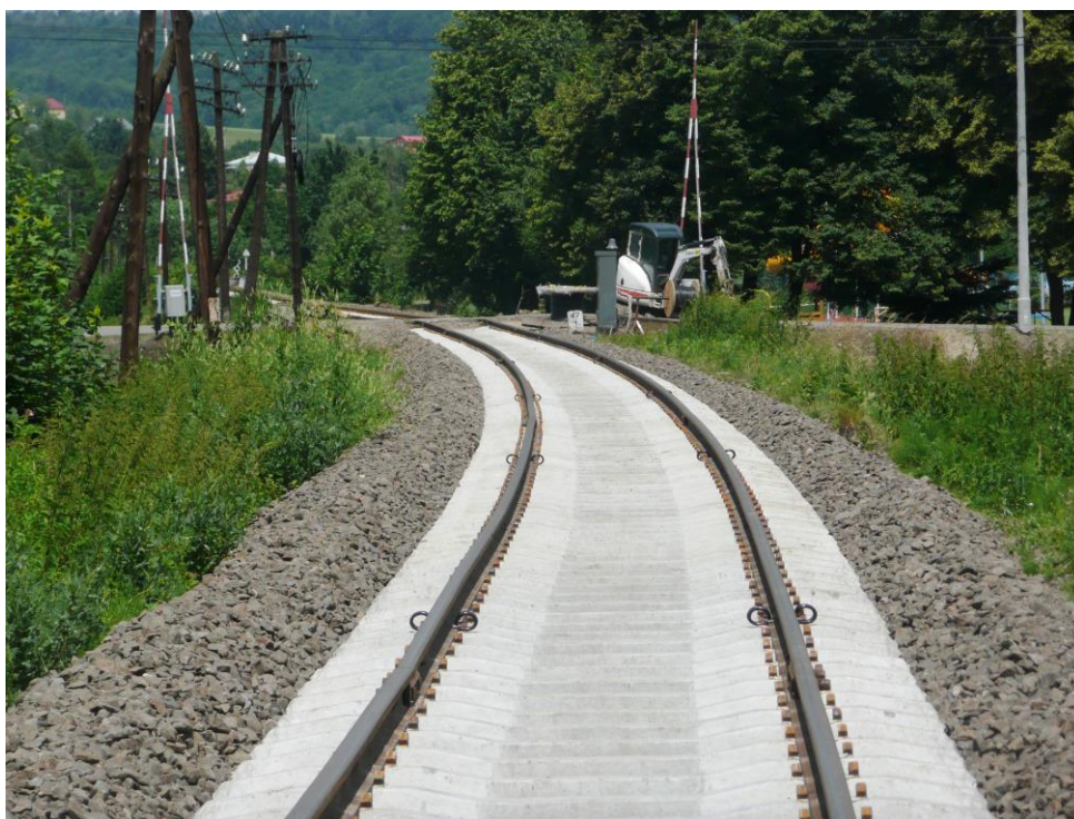
Fotografia nr 64 - Modernizacja linii kolejowej Rzeszów - Jasło
