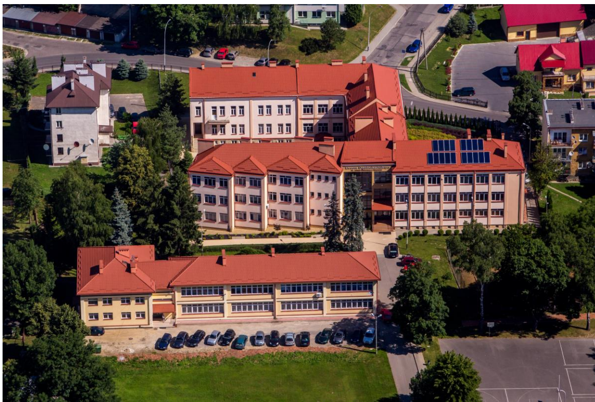
Fotografia nr 42 - Projekty samorządu powiatowego w Strzyżowie: Kompleksowa termomodernizacja budynku A Zespołu Szkół w Strzyżowie wraz ze zmianą źródeł wytwarzania energii, wykonanie mechanicznej wentylacji z odzyskiem ciepła w budynku Starostwa Powiatowego w Strzyżowie , wartość projektu: 1657347,14 zł, okres realizacji - lata: 2010 - 2011
